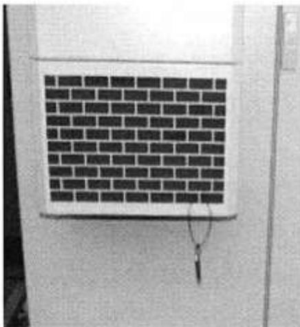
Abbildung 8-11 Lüfter im Schaltschrank
